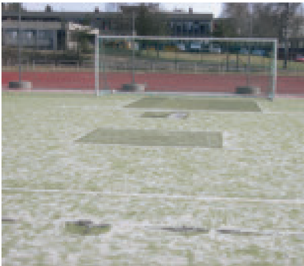
Utslitt dekke med åpne skjøter og felt
