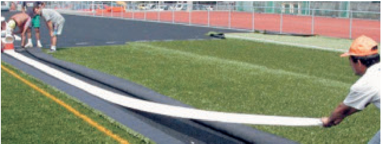
Liming av skjøter
